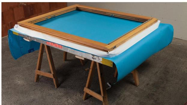
CONTEGA SOLIDO EXO se aplică înainte de montarea ferestrei. Cadrul ferestrei se poziționează pe un suport.
