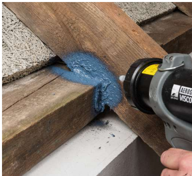
Sigilare simplă, rapidă și etanșă a rosturilor traverselor (de ex. căpriorii la renovarea acoperișului)
