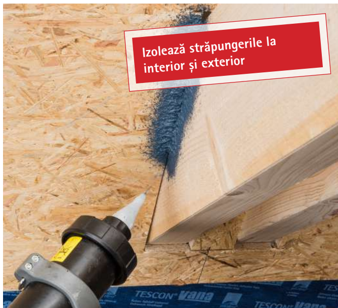
Sigilare simplă, rapidă și etanșă a rosturilor traverselor (de ex. căpriorii la renovarea acoperișului)
