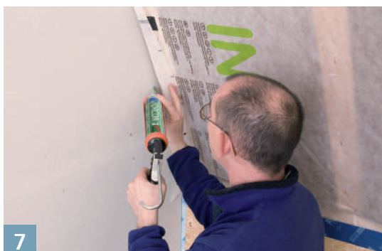
ORCON F Creează îmbinări sigure cu componentele zgrunțuroase sau minerale ale clădirii
