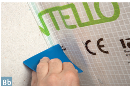
ORCON MULTIBOND Creează îmbinări sigure cu componentele zgrunțuroase sau minerale ale clădirii; îmbinările pot fi supuse sarcinilor imediat
