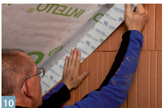
CONTEGA SOLIDO SL Formează legături adezive cu suprafețele minerale, poate fi tencuit; asigură îmbinări sigure și etanșe pe toate suprafețele
