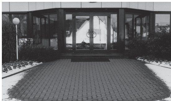
Fig. 92 Încălzirea prin pardoseală în aer liber
